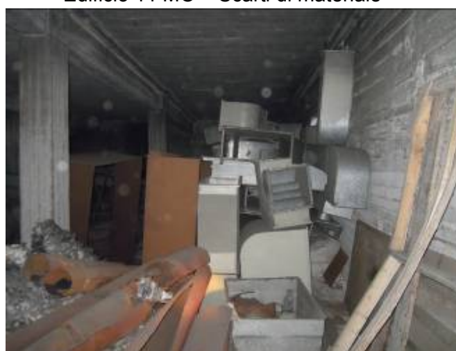
Edificio 11 MO – Scarti di materiale
