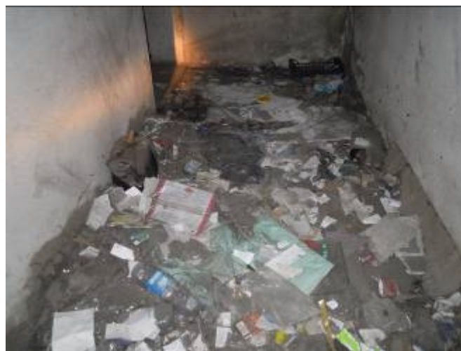
Edificio 10 MO – Rifiuti
