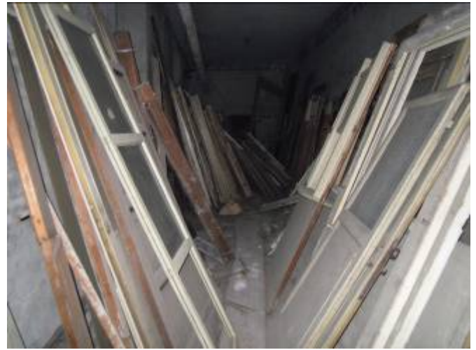
Edificio 04 PL – Scarti di materiale
