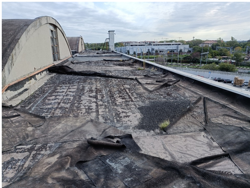
Copertura alta, fronte sud
