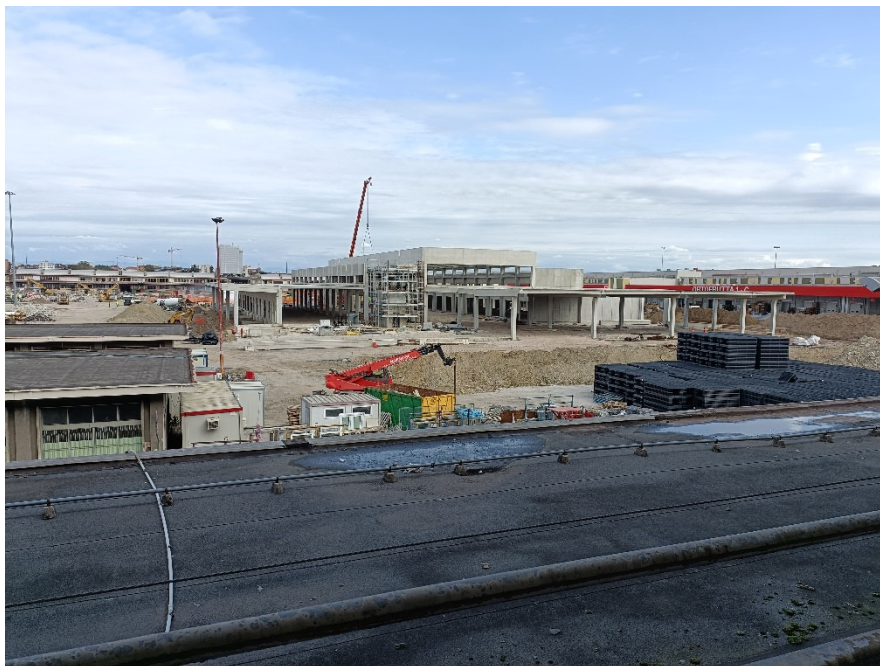
Copertura tettoia, fronte nord
