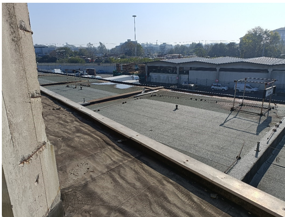
Copertura bassa, fronte sud
