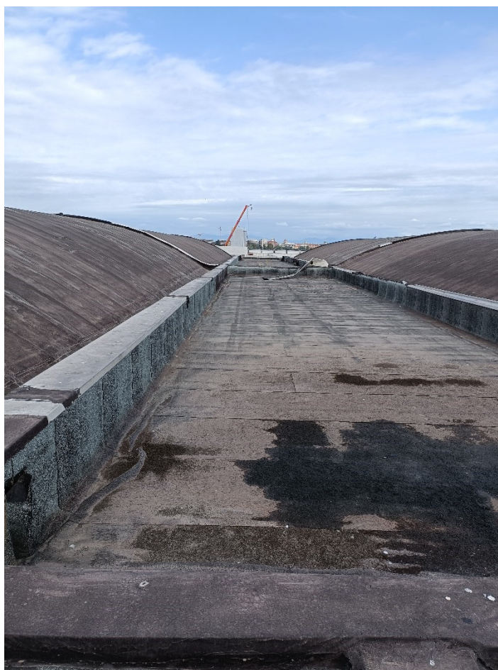
Copertura alta, corridoio di connessione asse N-S
