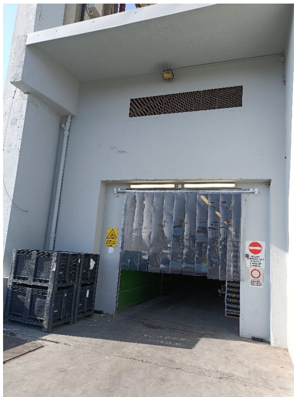
Fronte est, zona di accumulo acqua piovana
