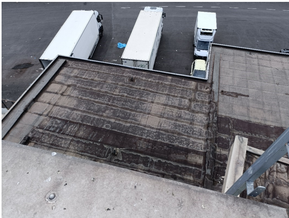
Copertura bassa, fronte sud
