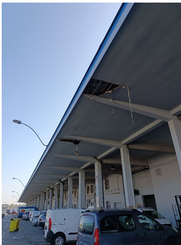
Tettoia fronte nord
