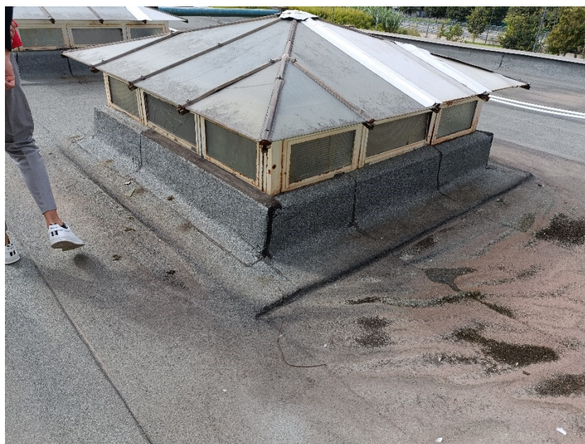
Dettaglio cupolino, copertura intermedia porzione sud-ovest
