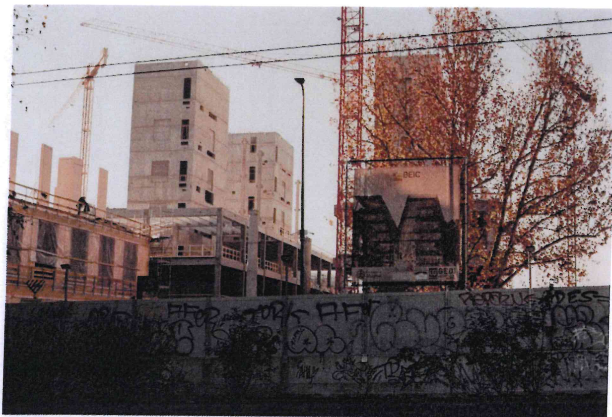
Il cantiere della Biblioteca Europea dell'Informazione e della Cultura, visto da via Molise © Davide Del Monte
